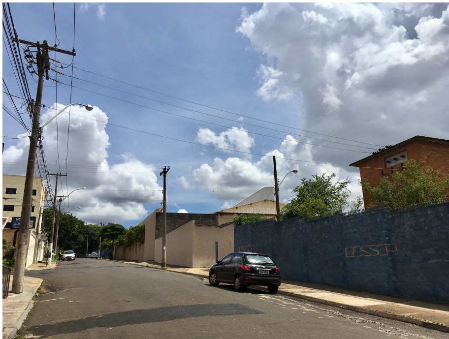
Figura 5.1: Ligação entre a Rede de Concessionária e a Rede Interna da UC.
