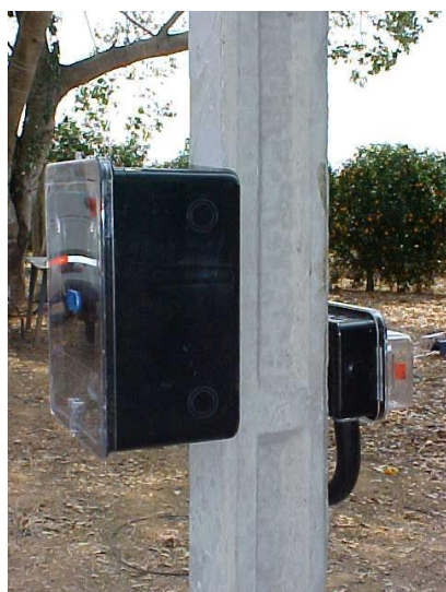
Padrão compacto com caixa de medição em policarbonato para 1 cliente residencial, obrigatoriamente voltado para a calçada. Ver GED 4.216.
