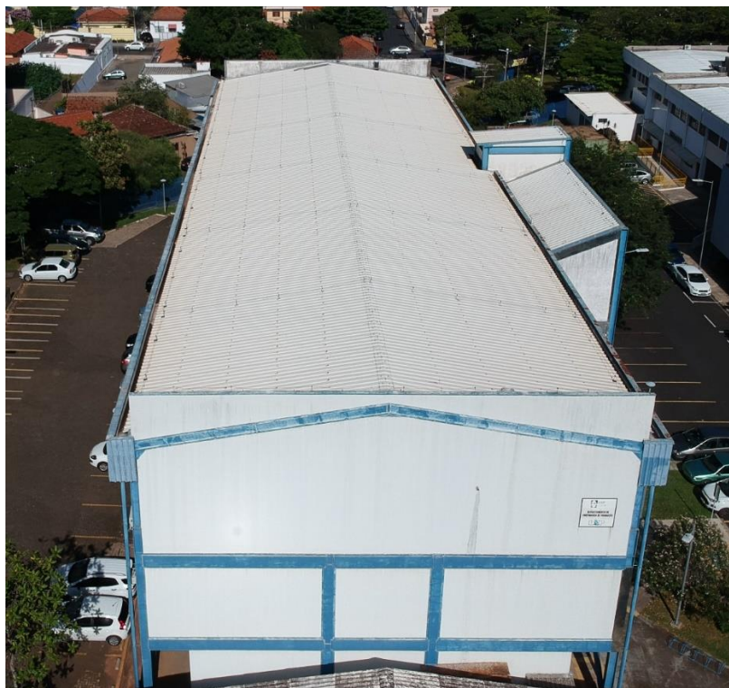
Figura 8: Visão aérea do bloco didático B, com telhado de telhas metálicas.
