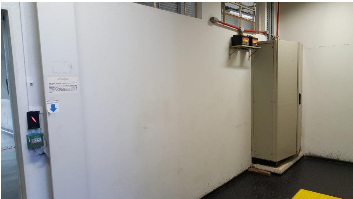
Figura 21: Parede em frente a escada, no primeiro andar, do quadro geral do bloco B.
