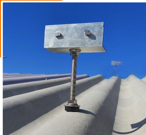
Solução com parafuso estrutural e fixação lateral no perfil
