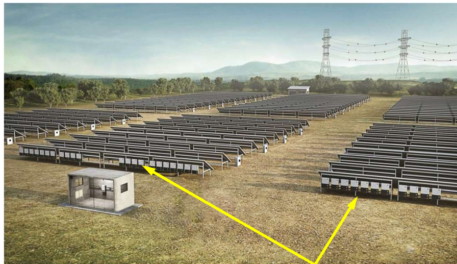
Inversores String Descentralizado
