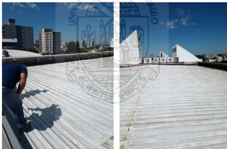
Figura 103: (IFSC – A) Vista telhado onde serão colocados os módulos fotovoltaicos.
