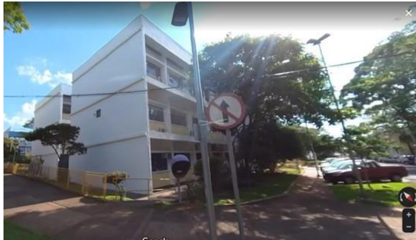
Figura 95: (IFSC - C) Vista de Frente do prédio do lugar da instalação.
