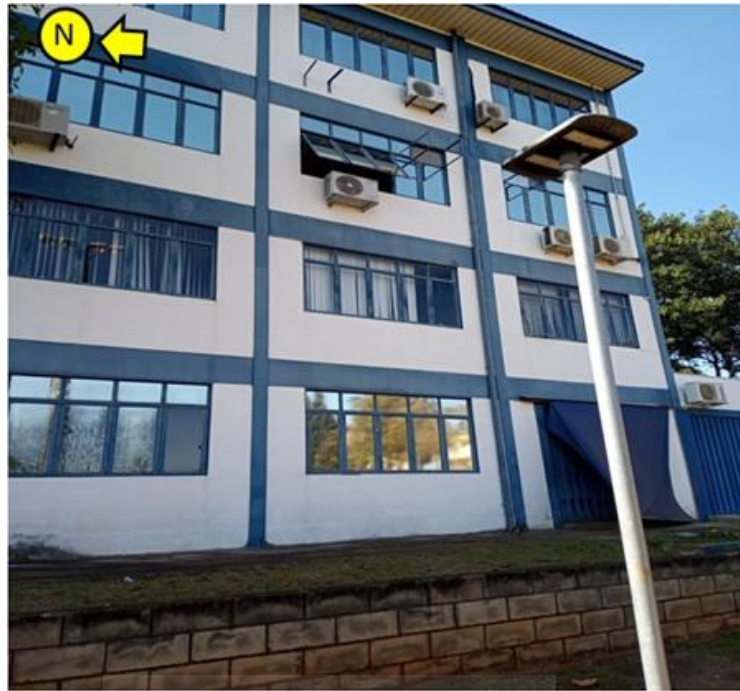
Figura 38: (EESC-SELN) Vista de Frente do prédio do lugar da instalação.
