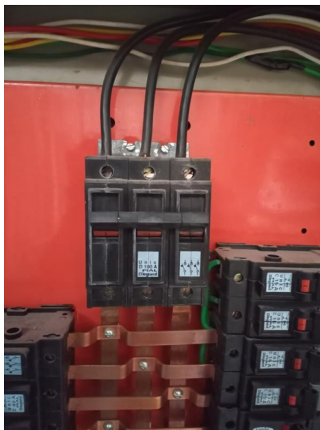
Figura 101: (IFSC - C) Disjuntor do Quadro de Distribuição Principal CA, 220V.
