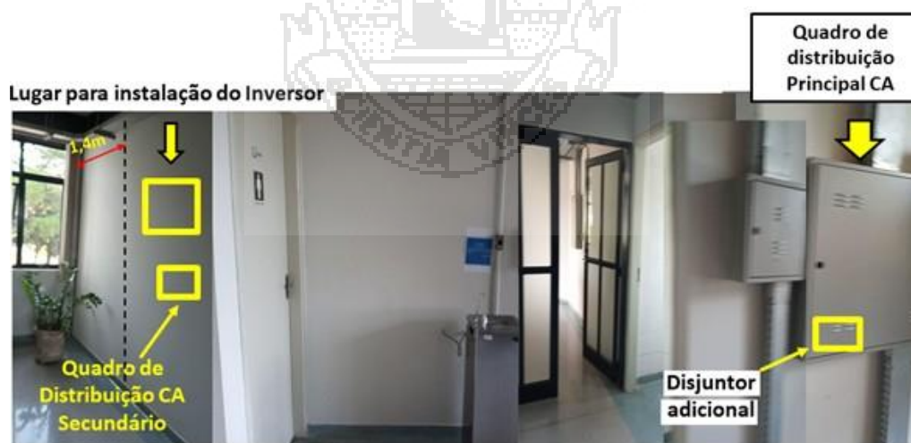
Figura 40: (EESC-SELN) Vista de cima do lugar da instalação com distâncias e layout dos módulos.
