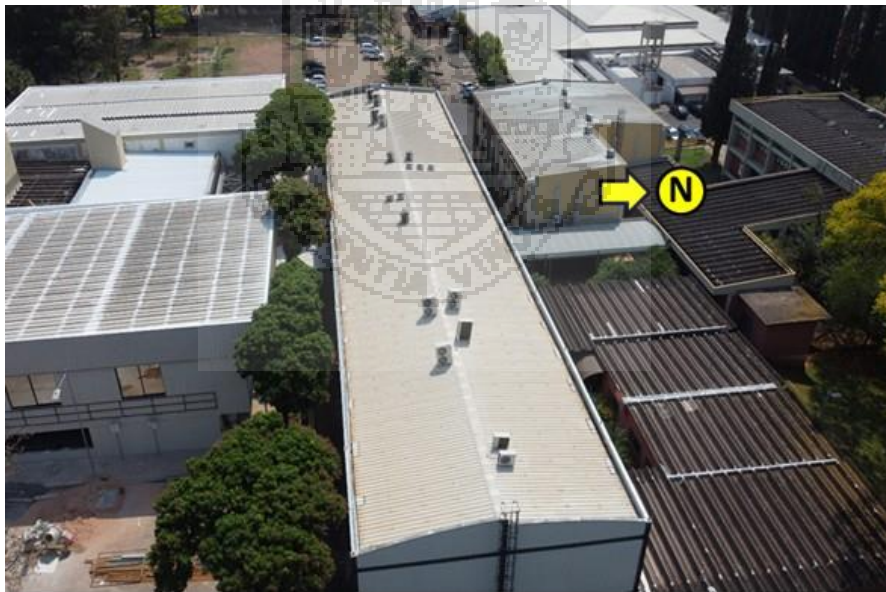
Figura 45: (EESC - CETE) Vista de cima do lugar da instalação.
