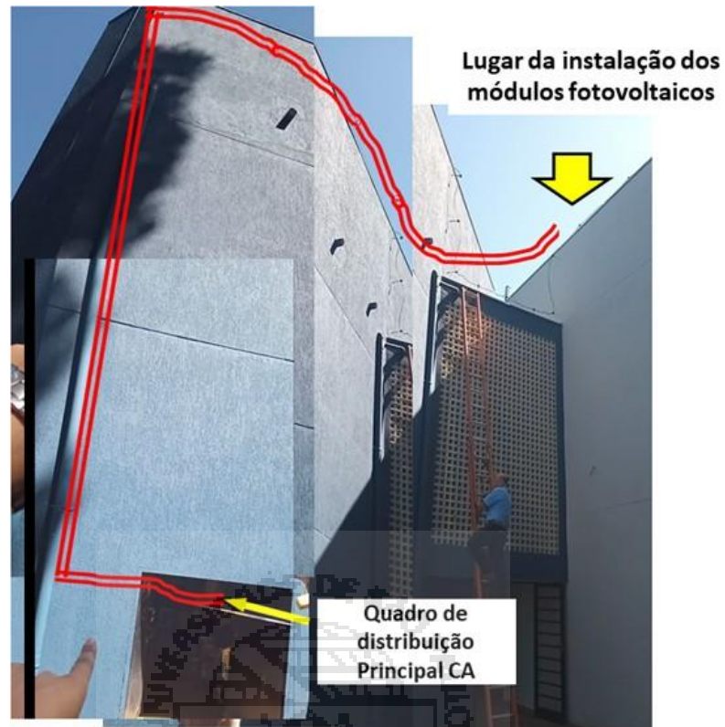
Figura 74: (IQSC - Q5) Sugestão do caminho dos eletrodutos dos módulos até o inversor fotovoltaico.
