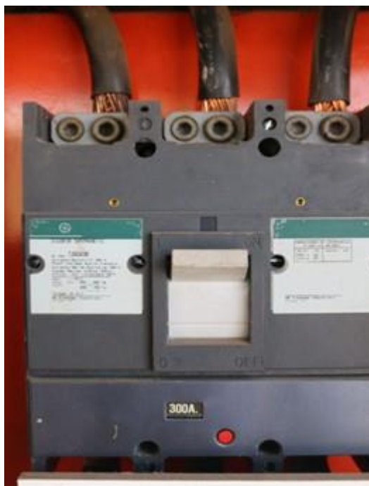
Figura 122: (PUSP-SC - SEVe) Disjuntor do Quadro de Distribuição Principal CA, 220V.
