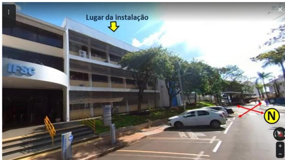
Figura 102: (IFSC – A) Vista de Frente do prédio do lugar da instalação.
