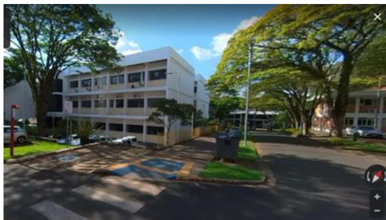
Figura 87: (IFSC-D) Vista de Frente do prédio do lugar da instalação.
