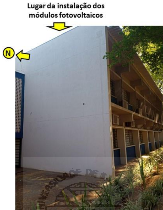
Figura 68: (IQSC - Q5) Vista de frente do prédio do local de instalação.
