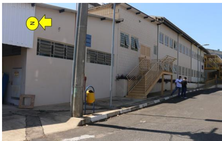
Figura 115: (PUSP-SC - SEVe) Vista da altura do prédio do lugar da instalação.
