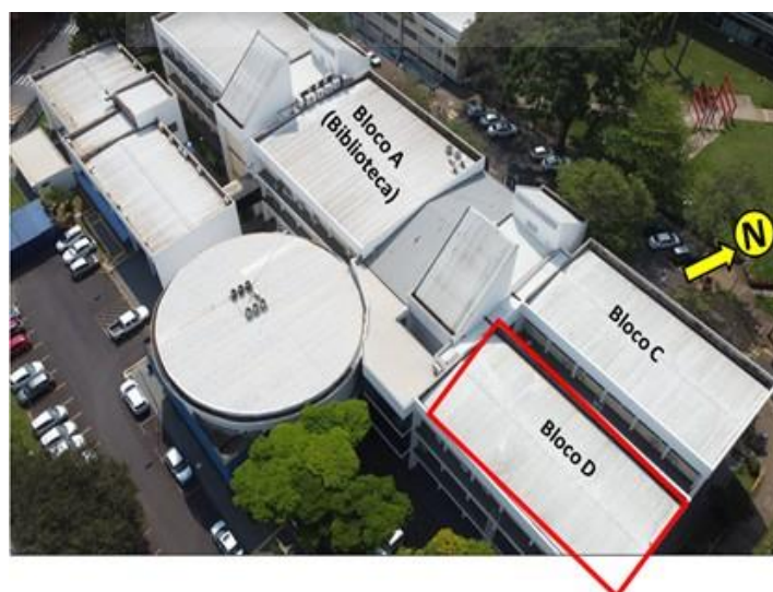
Figura 89: (IFSC-D) Vista de cima do lugar da instalação.
