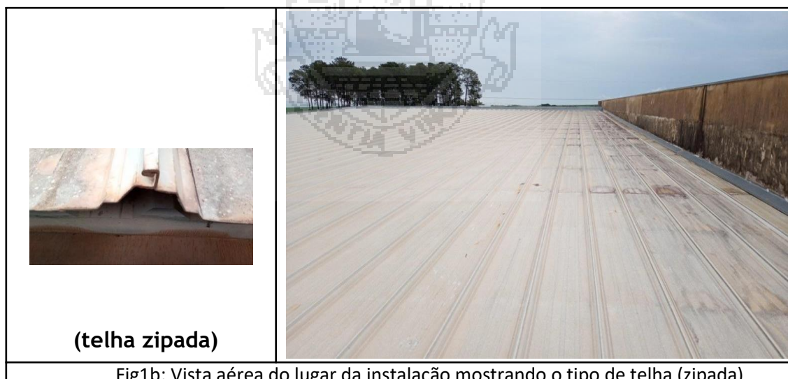
Fig1b: Vista aérea do lugar da instalação mostrando o tipo de telha (zipada)
