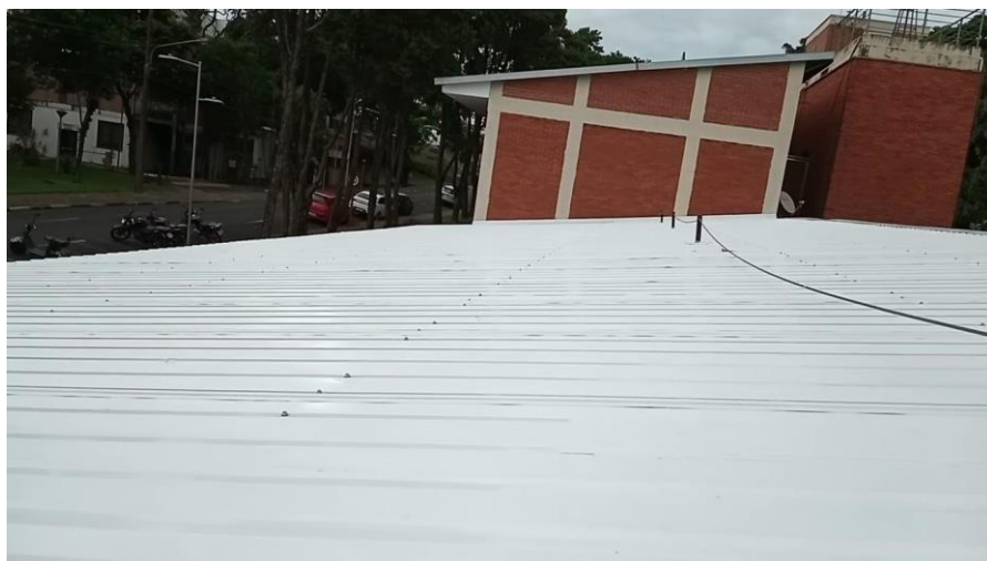
Figura 52: (EESC-TRAN) Vista de Cima do prédio do lugar da instalação (telhado com queda no leste).
