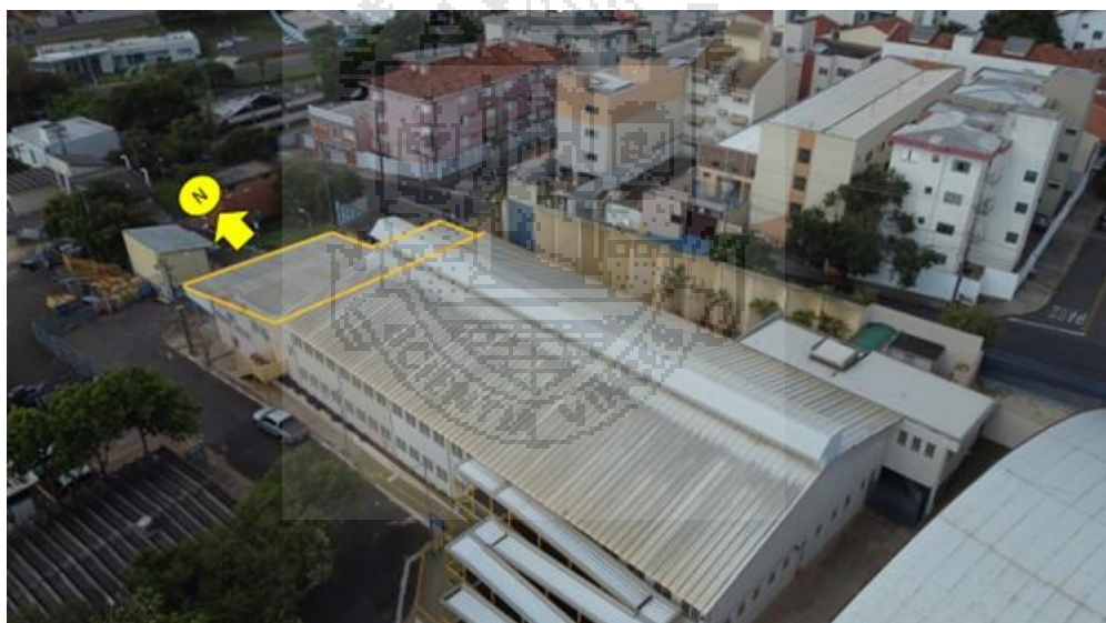
Figura 118: (PUSP-SC - SEve) Vista aérea do lugar da instalação.
