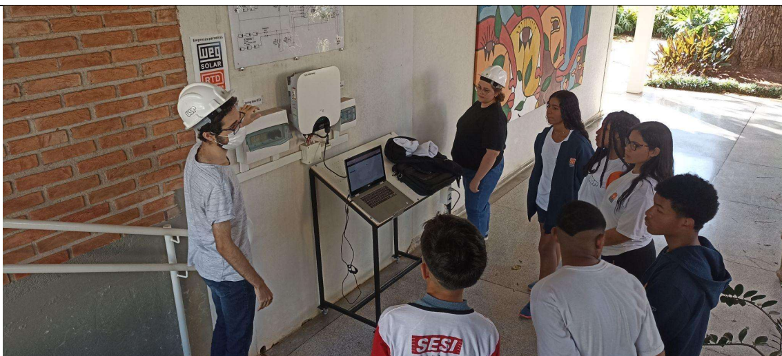
Fig2b: Explicação do sistema fotovoltaico ligado à rede (ongrid) (Projeto pequeno cidadão PUSP-SC/USP)
