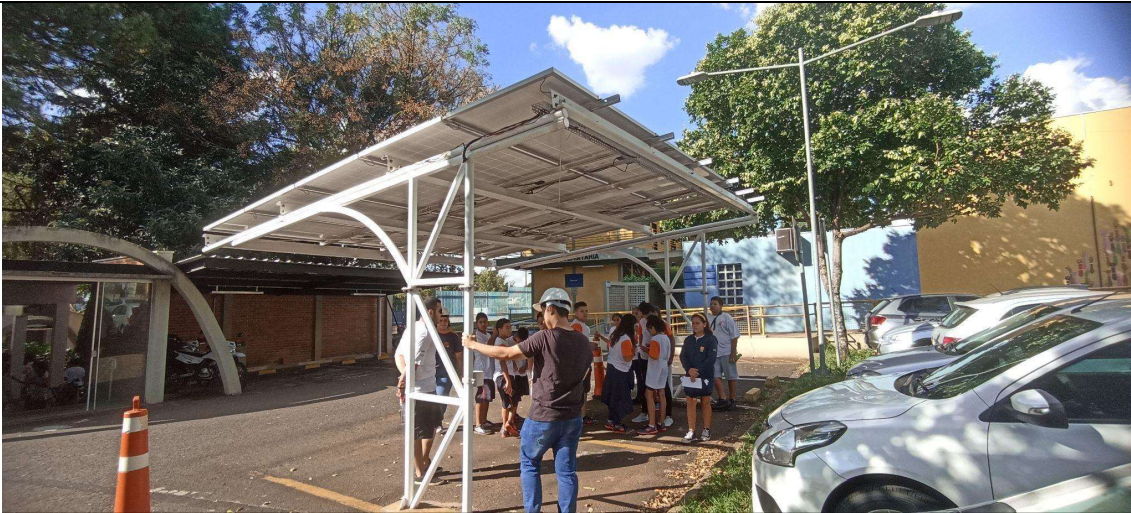
Fig2a: Explicação do Carport Solar USP – Sistema “Ongrid” (Projeto pequeno cidadão PUSP-SC/USP)
